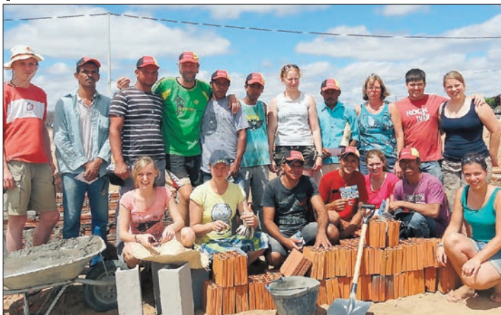
Die Projektgruppe aus der Anna-Katharina-Gemeinde mit den brasilianischen Helfern auf der Baustelle. In wenigen Jahren soll hier ein Kinderhaus entstehen.
